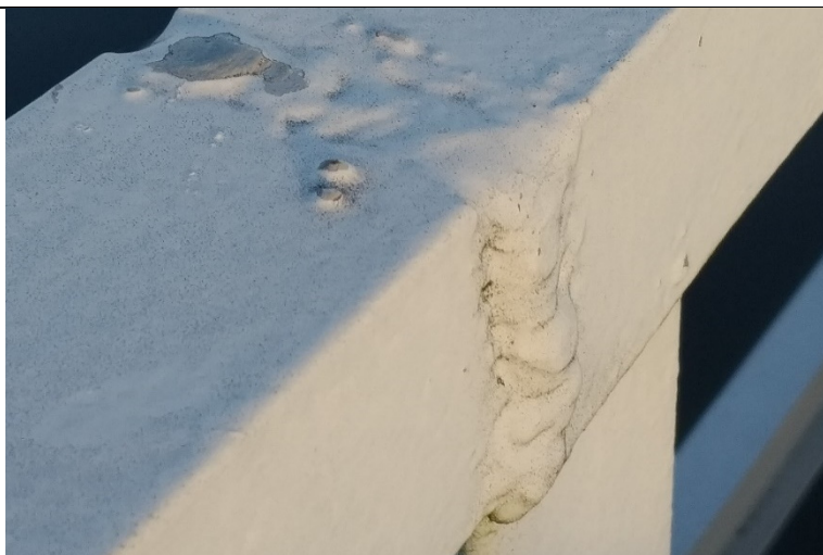
Obr. 45: Nevyhovující svary na podružných částech konstrukce
