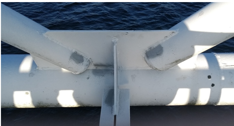
Obr. 60: Aplikace provizorního ochranného zinkového nástríku
