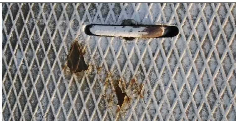
Obr. 44: Koroze pochozích ocelových plechů mostovky
