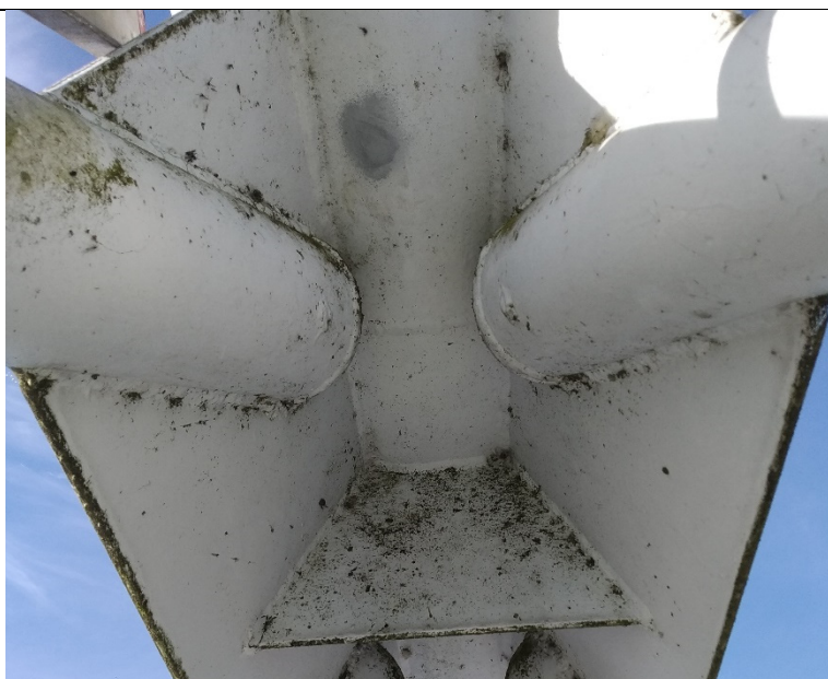
Obr. 11: Konstrukční detail napojení horního pasu a diagonál
