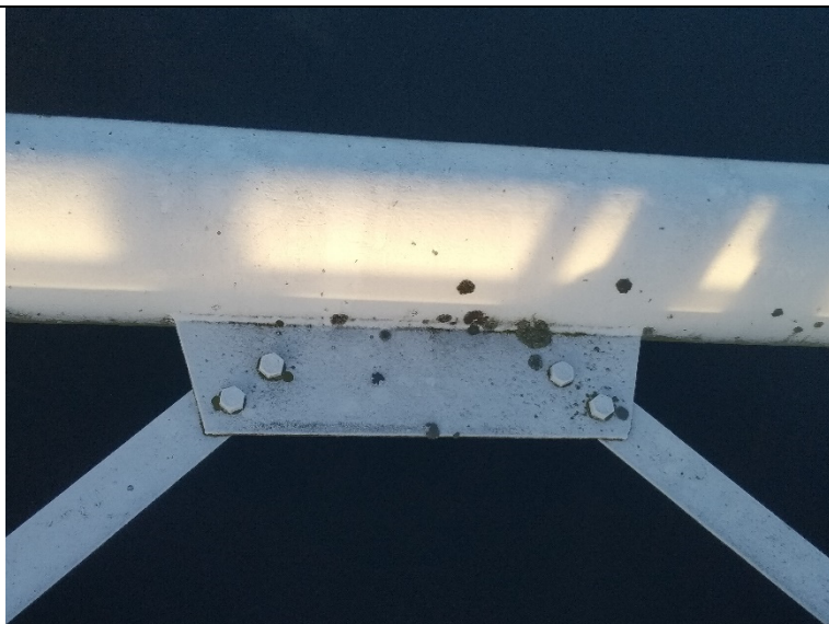
Obr. 25: Šroubový spoj podélného ztužení
