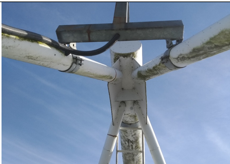
Obr. 9: Konstrukční detail napojení horního pasu a diagonál
