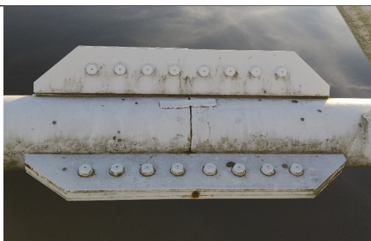
Obr. 24: Montážní šroubový styk dílců NOK
