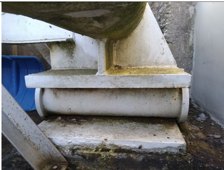
Obr. 13: Uložení konstrukce K01 na OP1
