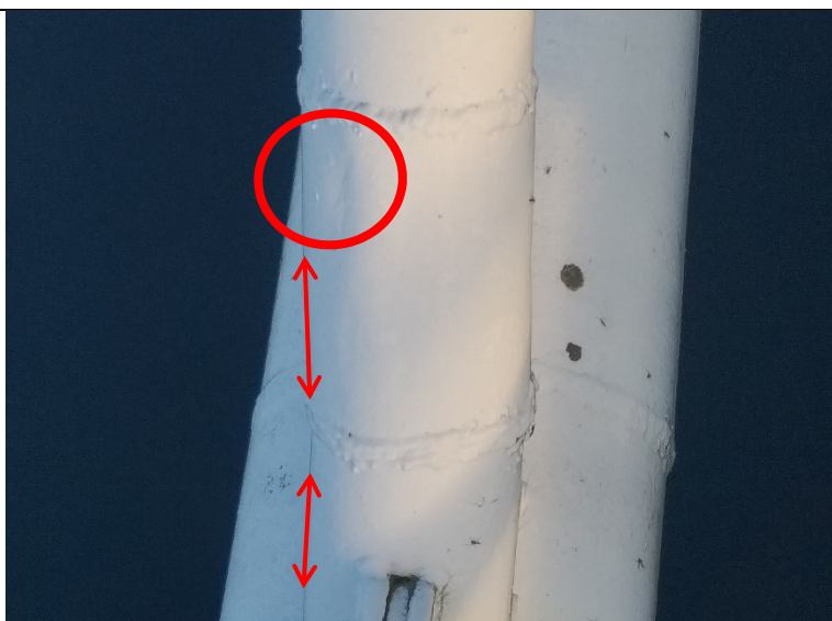
Obr. 36: Plastická deformace diagonály D13, úhlová deformace prvku
