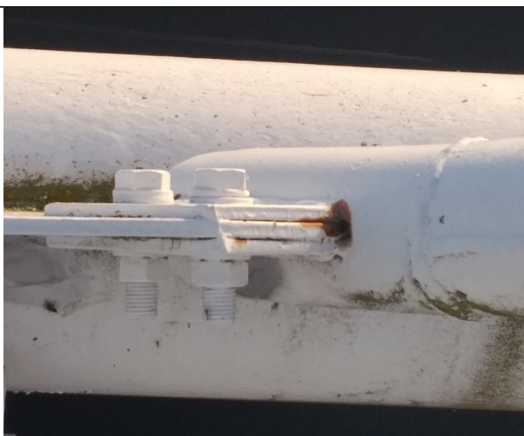
Obr. 29: Detail šroubového spoje diagonály
