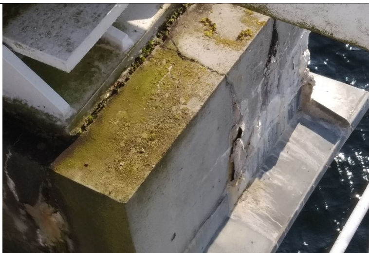
Obr. 53: Detail pevného ložiska K02 na opěře OP2 – P
