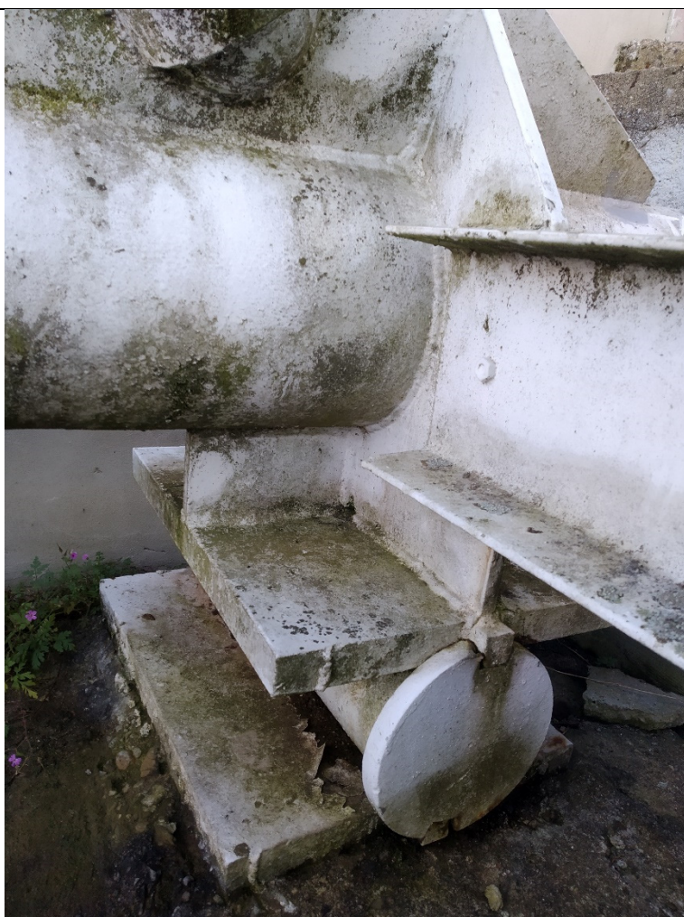
Obr. 15: Nadložiskový detail
