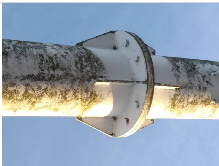
Obr. 30: Detail montážního spoje horního pasu
