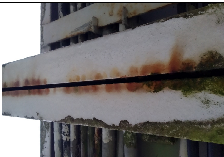
Obr. 40: Povrchová koroze příčníků
