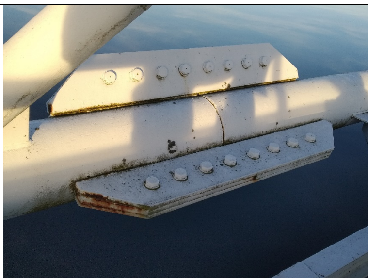
Obr. 23: Montážní šroubový styk dílců NOK
