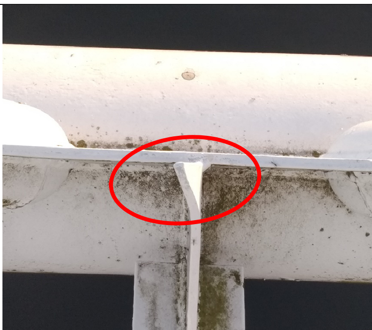
Obr. 35: Plastická deformace styčnickového plechu v poli 11
