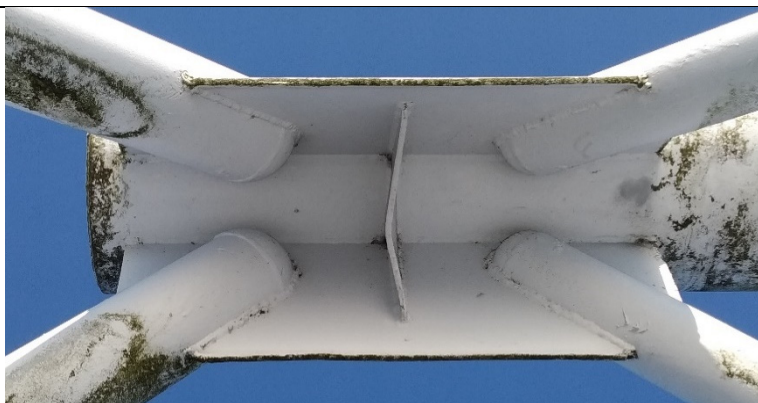
Obr. 49: Deformace příčné výztuhy styčnickového plechu
