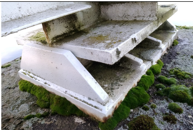
Obr. 43: Levé ložisko K01 na pilíři P1
