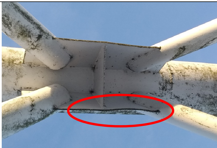
Obr. 19: Deformace styčnickových plechů
