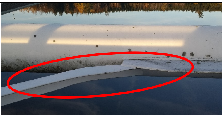
Obr. 34: Plastická deformace podélného ztužení v poli 10
