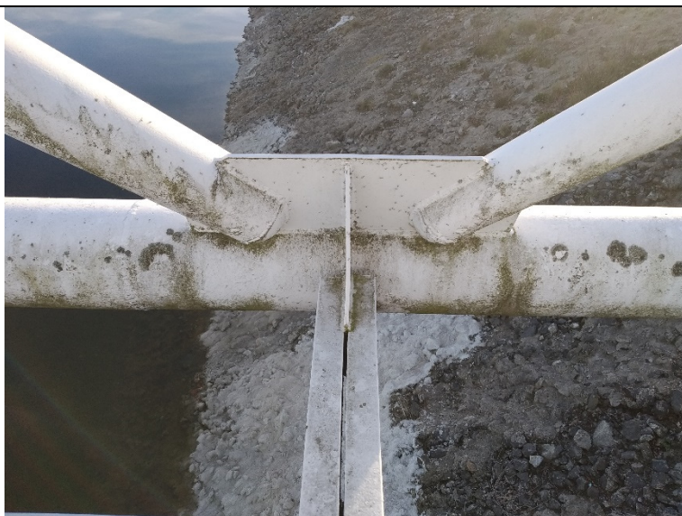
Obr. 16: Detail napojení diagonál a příčnicku k dolnímu pasu
