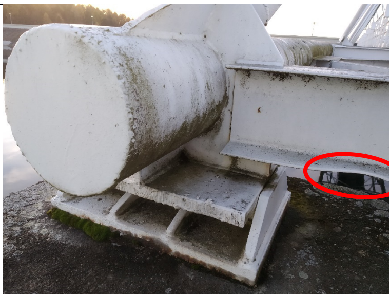
Obr. 42: Detail ložiska K01 na pilíři P1 a deformace příčniku
