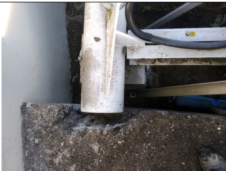
Obr. 14: Uložení konstrukce K01 na OP1
