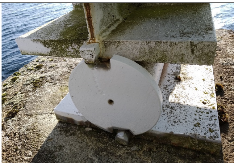
Obr. 48: Ložiska konstrukce K02 na pilíři P1
