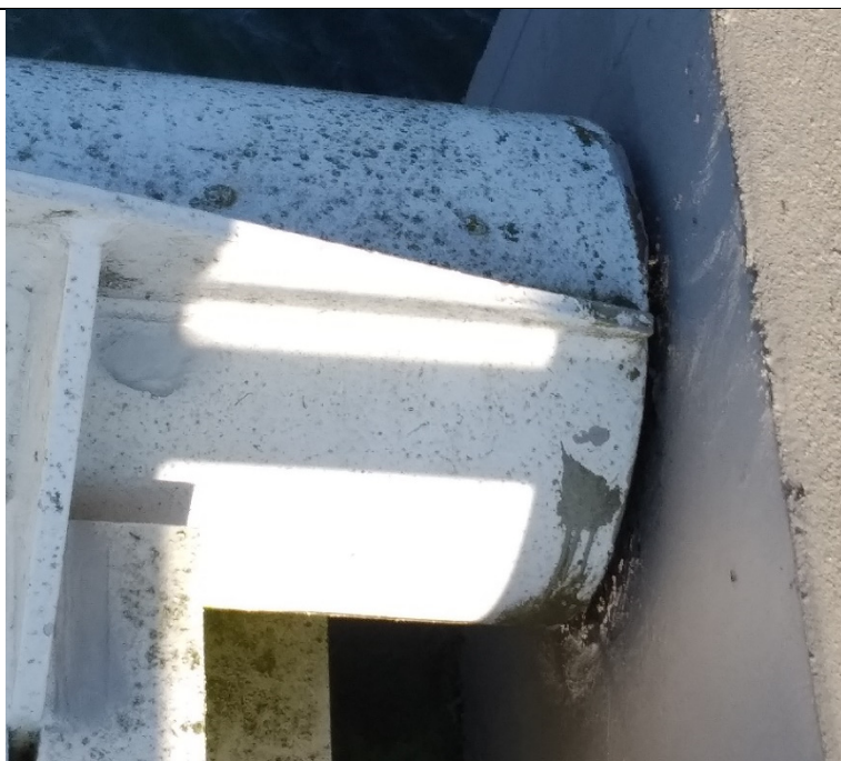
Obr. 55: Nedostatečná dilatace
