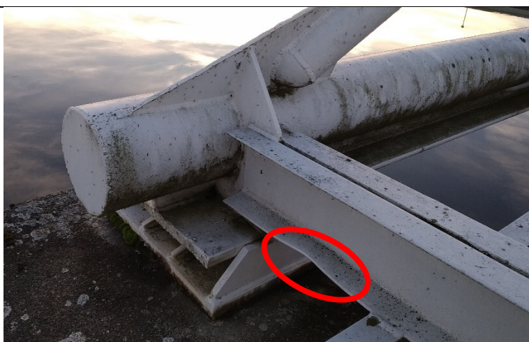
Obr. 41: Uložení konstrukce K01 na pilíři P1, plastická deformace příčniku
