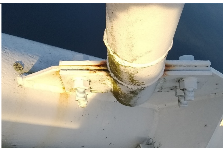
Obr. 27: Detail šroubového spoje diagonály
