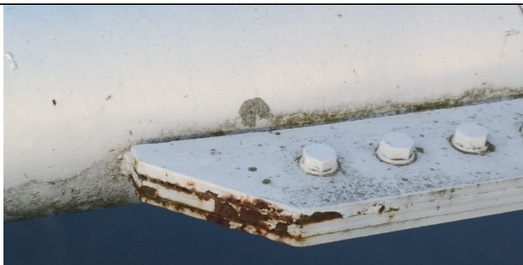
Obr. 37: Koroze, puchýřkování a odpadávání vrstev PKO
