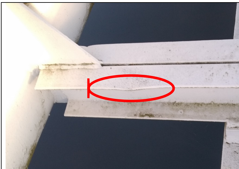
Obr. 22: Plastická deformace pásnice příčnicku
