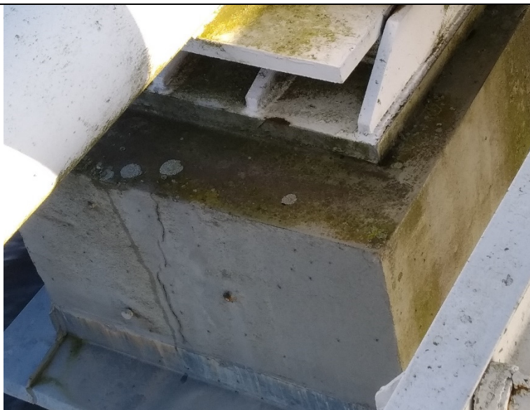
Obr. 54: Pevné ložisko K02 na opěře OP2 – L
