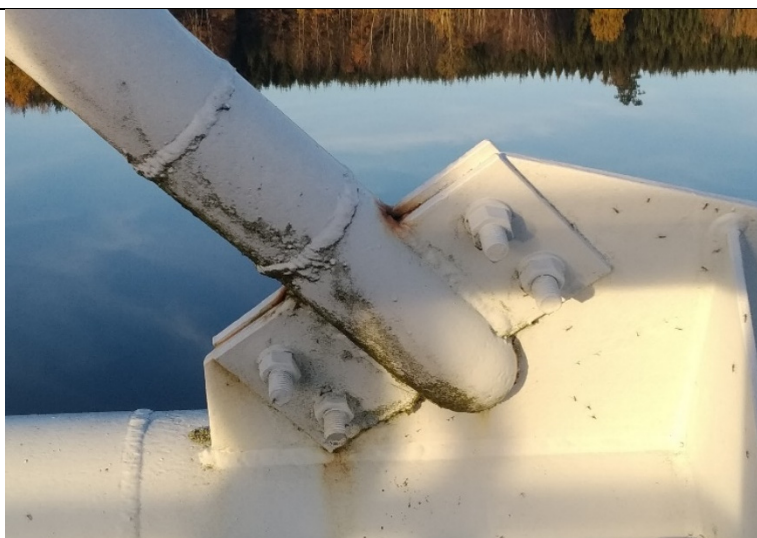
Obr. 26: Šroubový spoj diagonály
