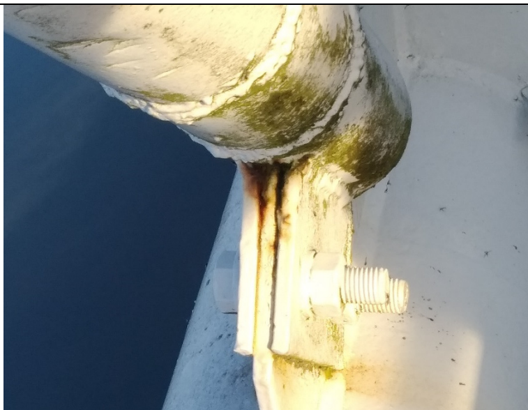
Obr. 28: Detail šroubového spoje diagonály
