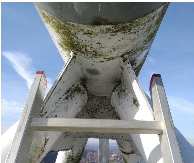
Obr. 10: Konstrukční detail napojení horního pasu a diagonál
