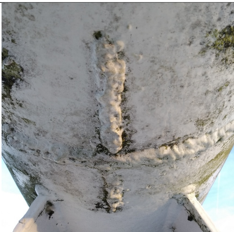
Obr. 38: Vady povrchu – horní pas
