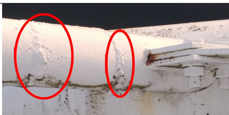
Obr. 32: Detaily povrchových vad svarů
